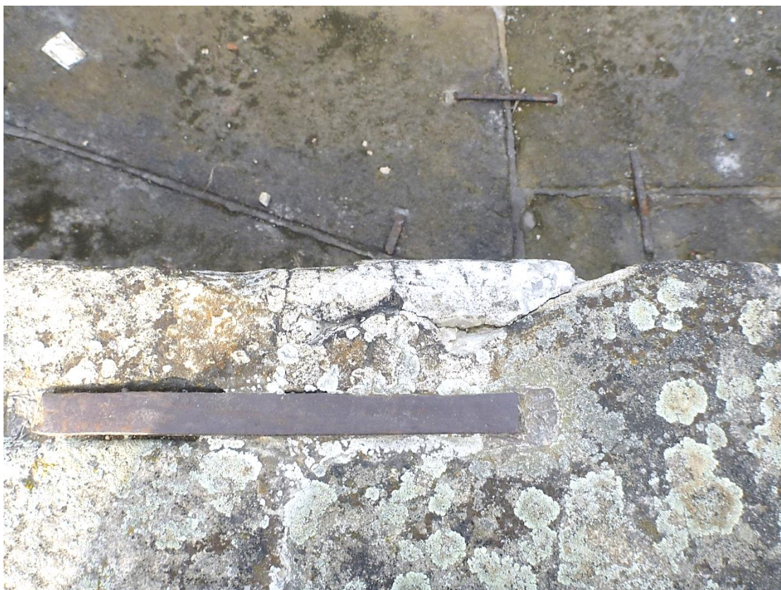
Kamenná kašna v areálu zámku Budkov – detaily dlažby dna nádoby a spojovacích kramlí
