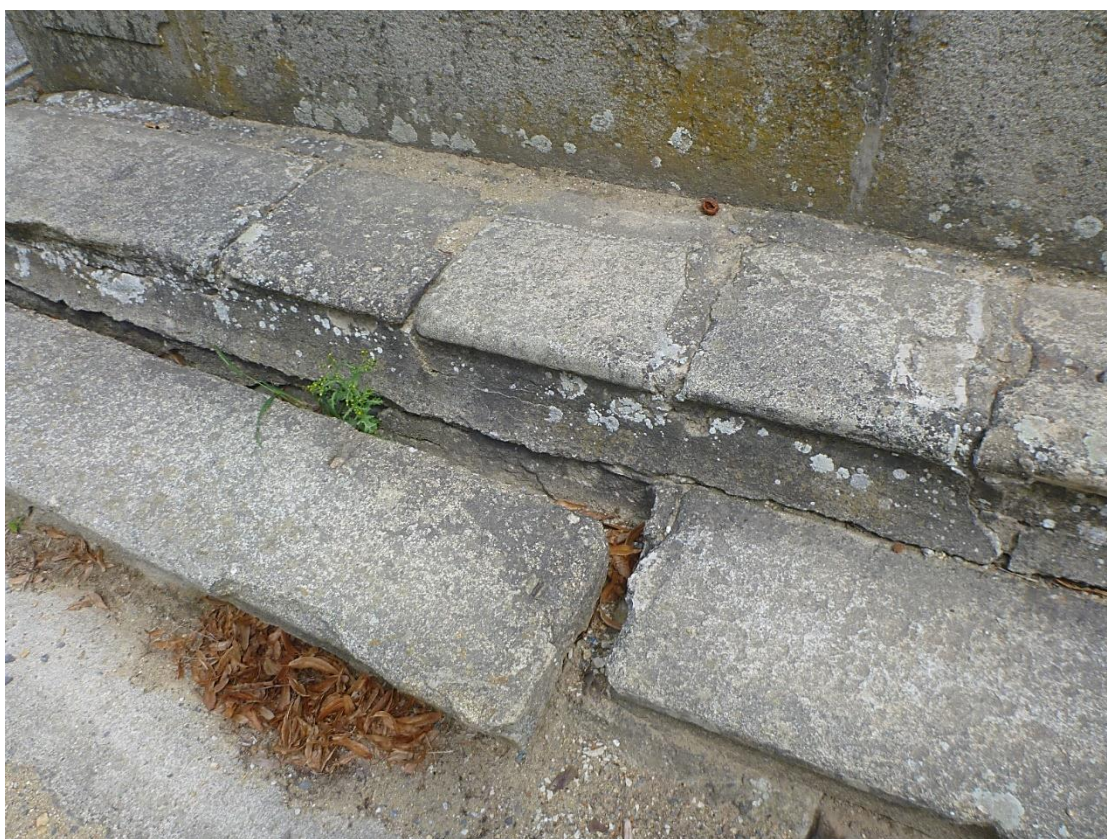
Kamenná kašna v areálu zámku Budkov – detail poškozené a uvolněné schodové základny – druhotně vložené prvky
