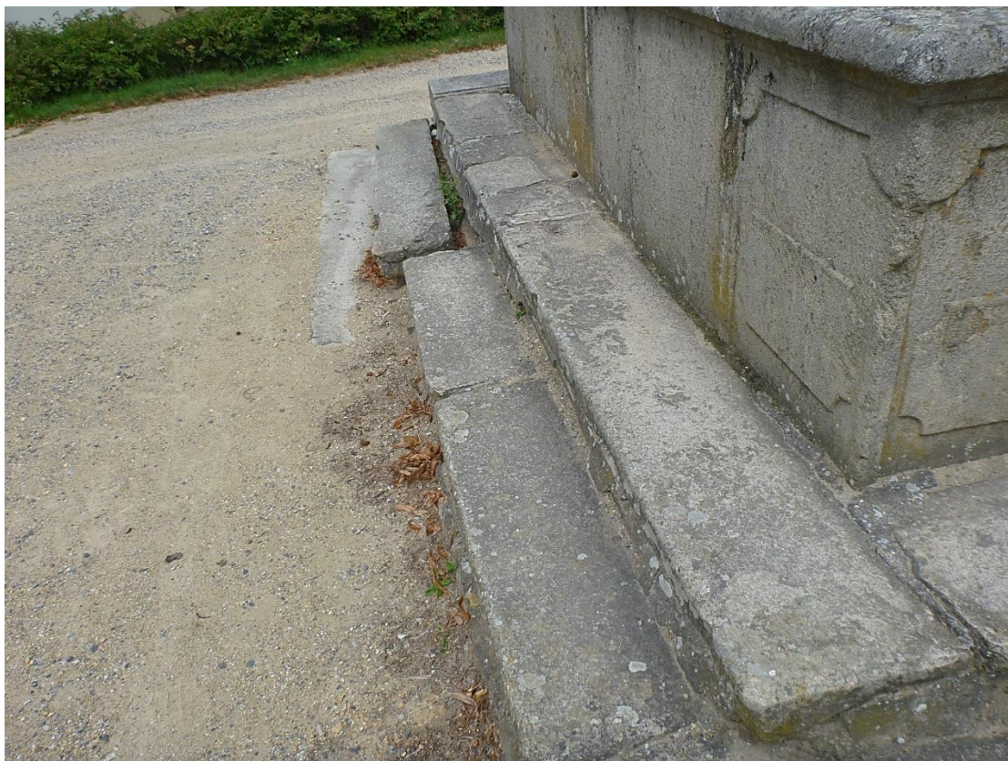
Kamenná kašna v areálu zámku Budkov – detail poškozené a uvolněné schodové základny
