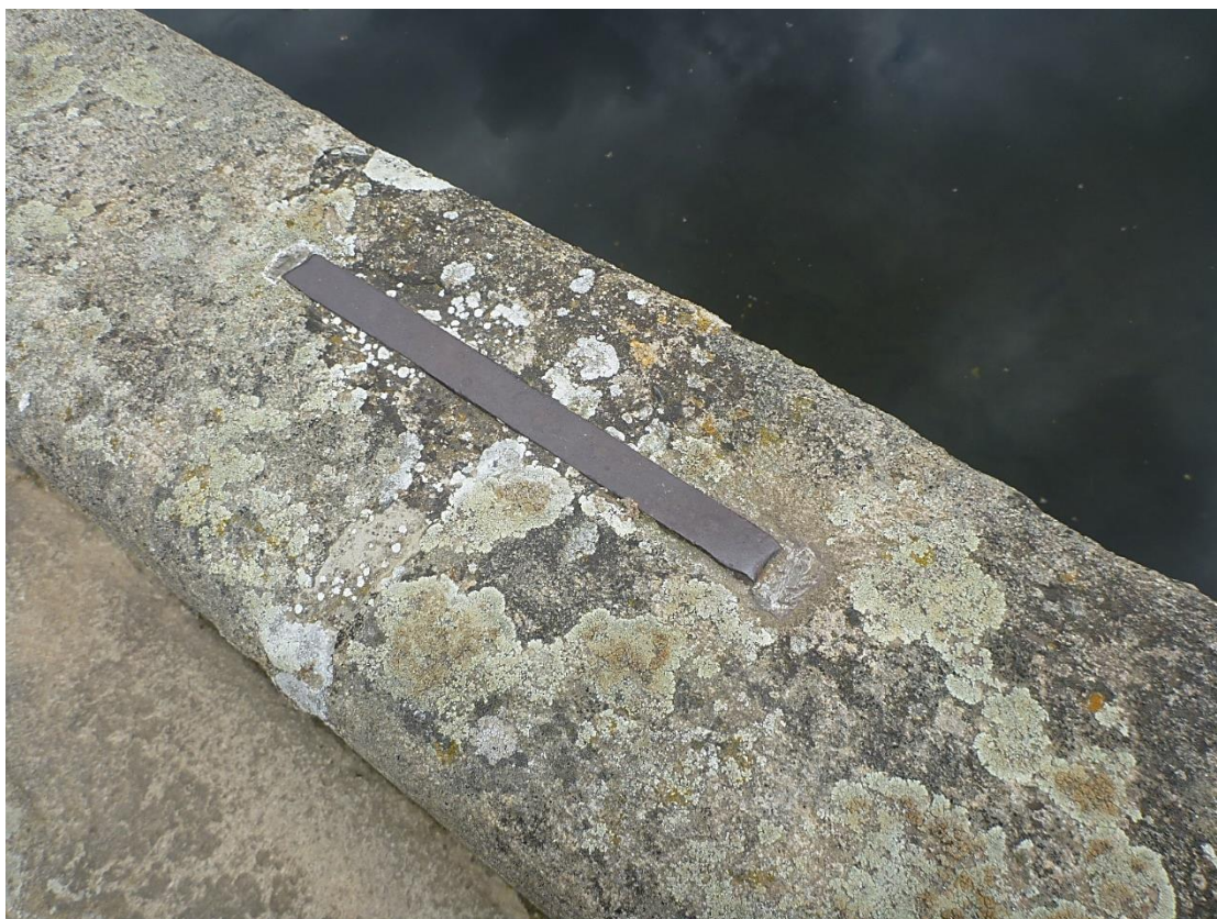
Kamenná kašna v areálu zámku Budkov – detail spojovacích kramlí na madle nádoby
