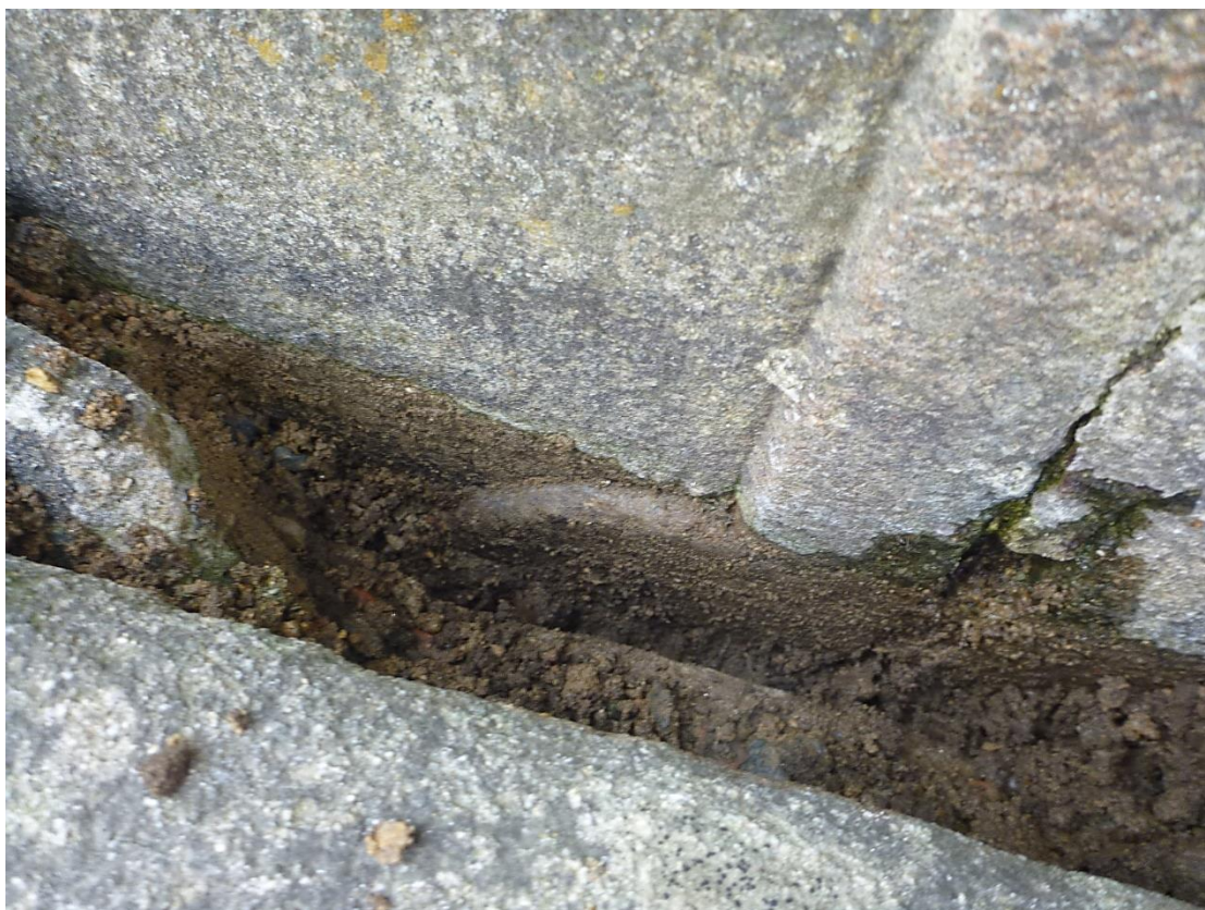
Kamenná kašna v areálu zámku Budkov – detail provedené sondy u paty stěn nádoby – skrytá část s plastickou výzdobou, provlhčená zemina od průsaků vody
