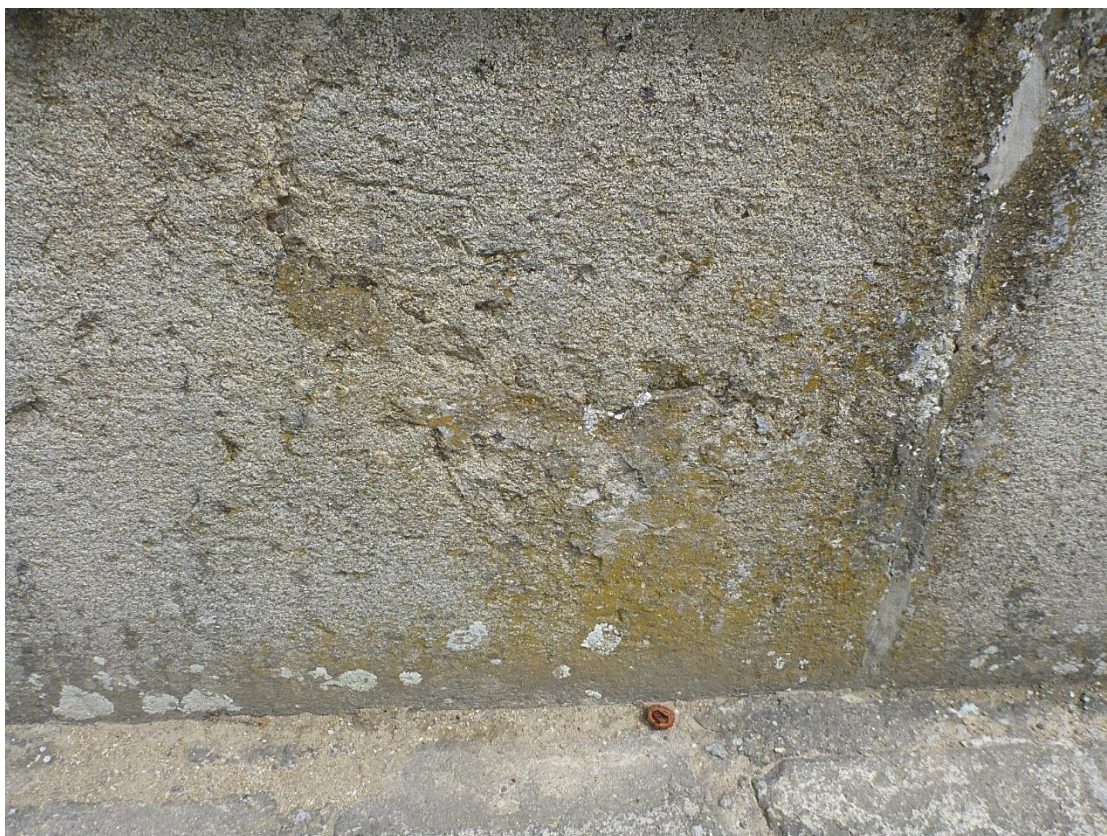
Kamenná kašna v areálu zámku Budkov – detaily narušení kamene, cementové tmely
