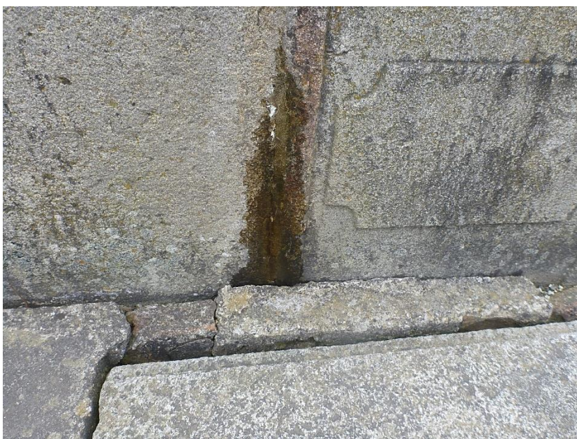
Kamenná kašna v areálu zámku Budkov – detail spár a průsaku vody
